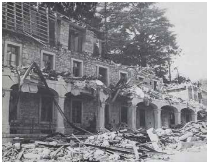
Magnano in Riviera subito dopo il terremoto.
